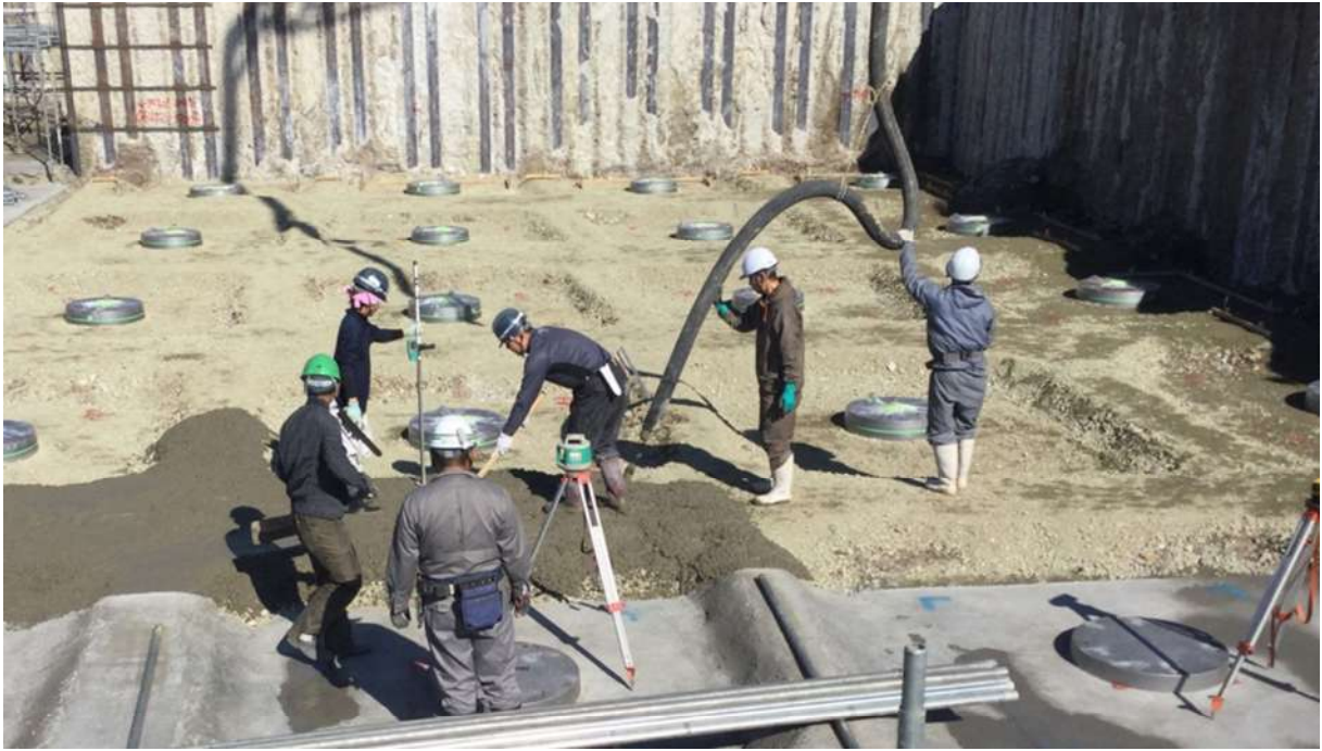
・ごみピット下部捨てコンクリート打設状況①
