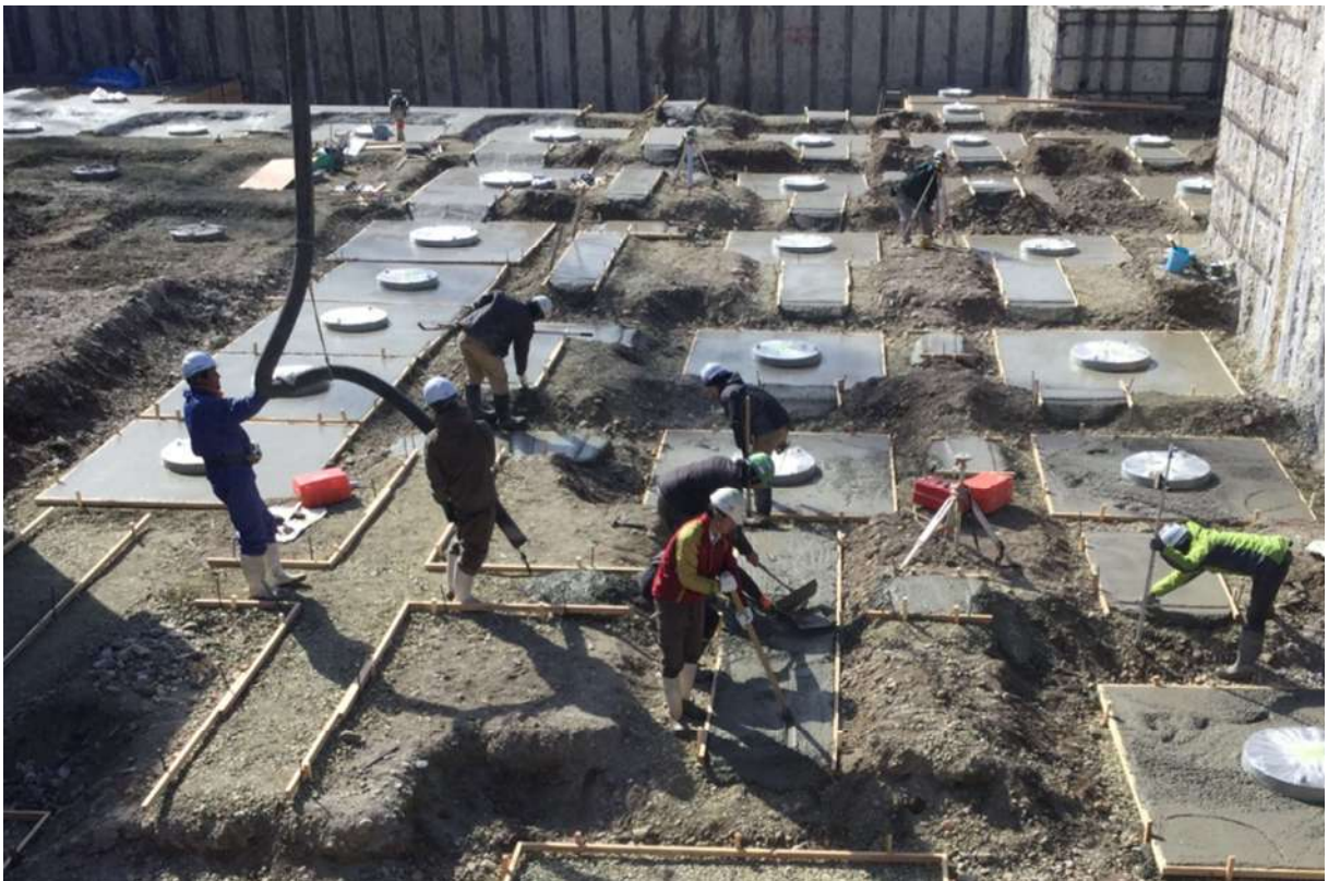
・ごみピット下部捨てコンクリート打設状況②
