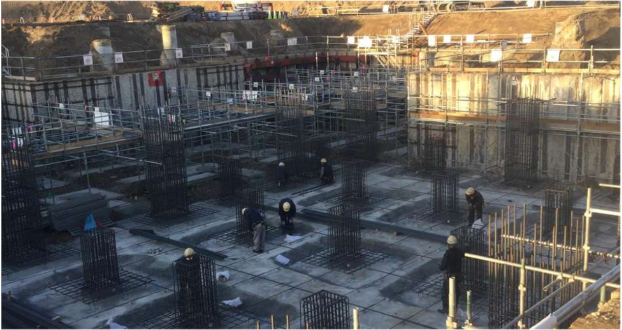
・ごみピット配筋状況①
