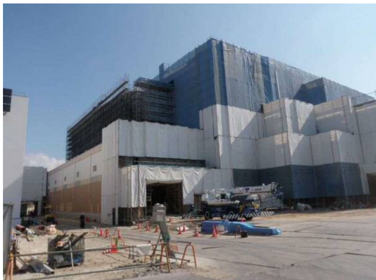
建築工事(工場棟)
