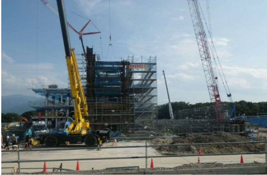
建築工事(鉄骨)
