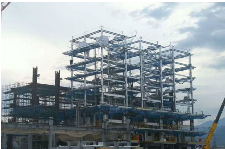
プラント工事(機器架構)
