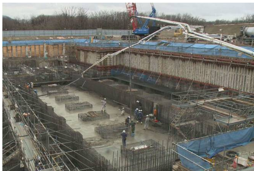
コンクリート工事
