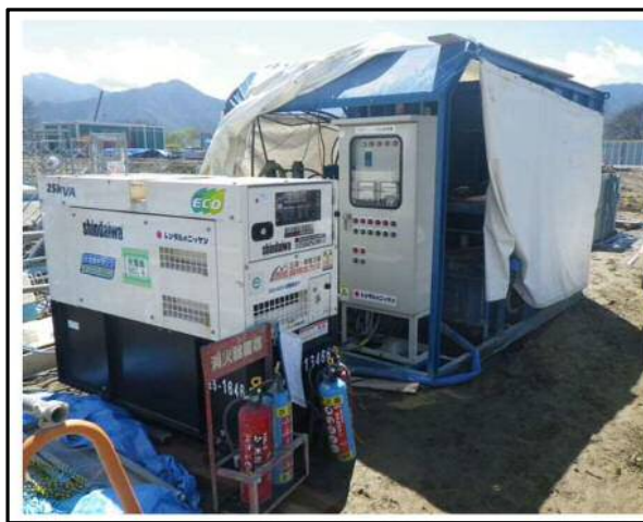
②濁水処理機の設置状況
