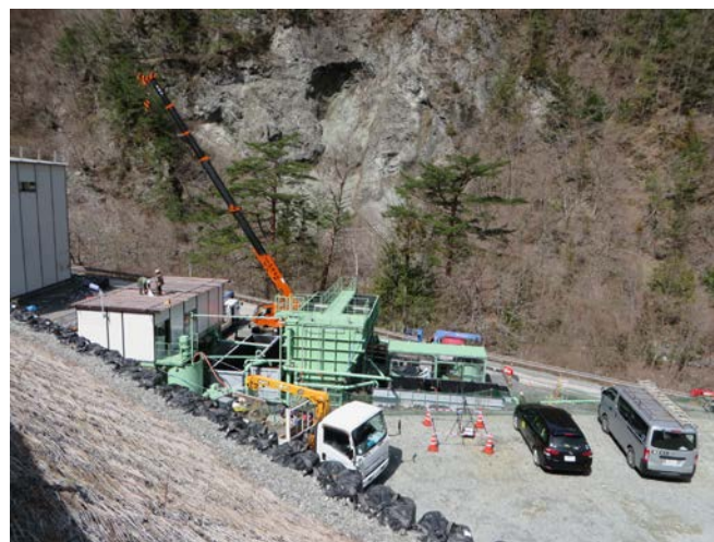
②プラント設備工
