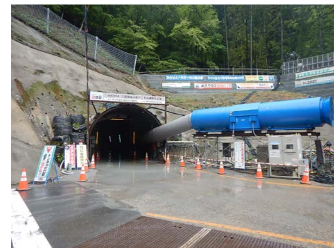
③調査坑坑口
