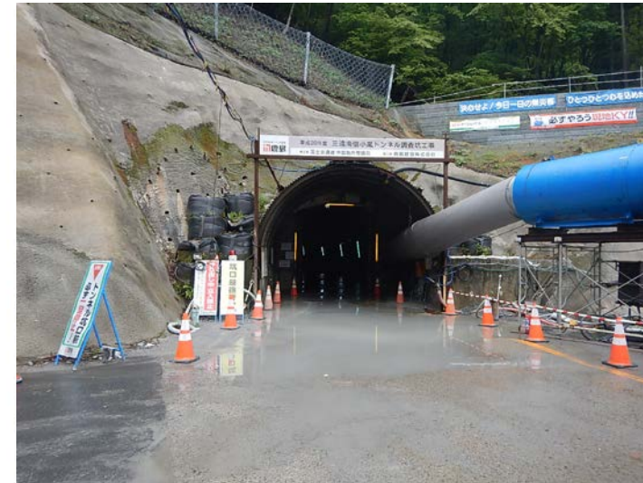
トンネル坑口
