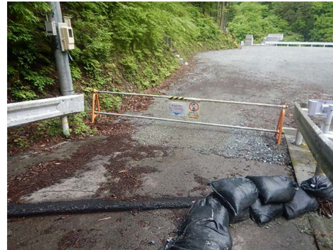
工事現場への立ち入り禁止柵
