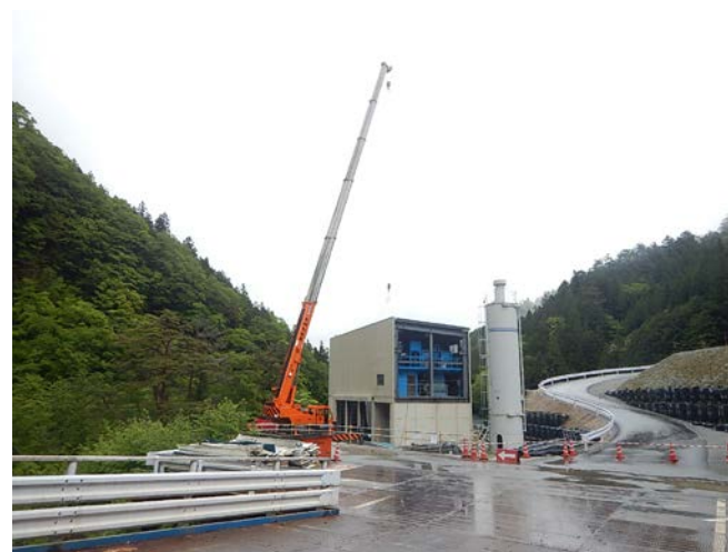
②構造物撤去工
