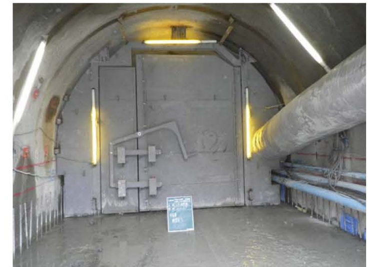
防音扉の設置
