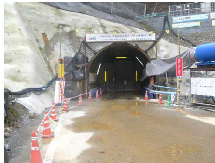
トンネル坑口
