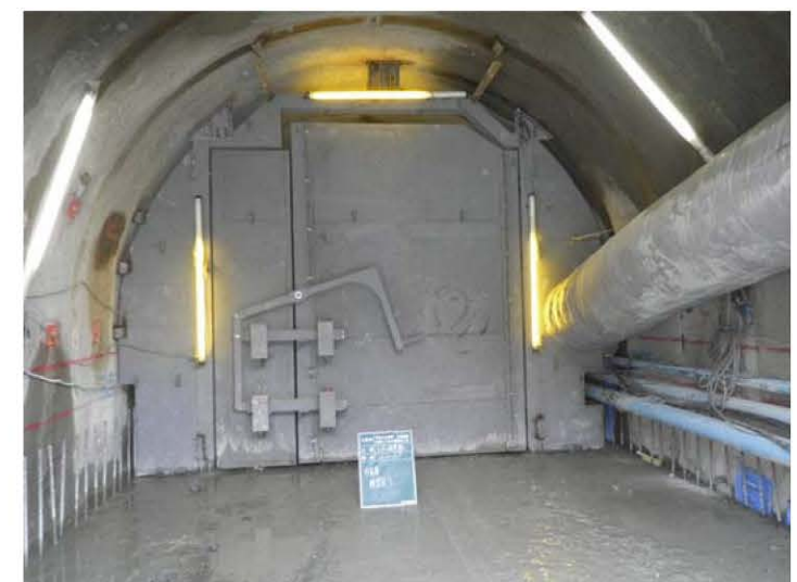
防音扉の設置
