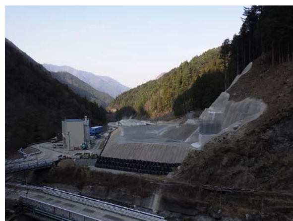
① 土工-橋梁部
