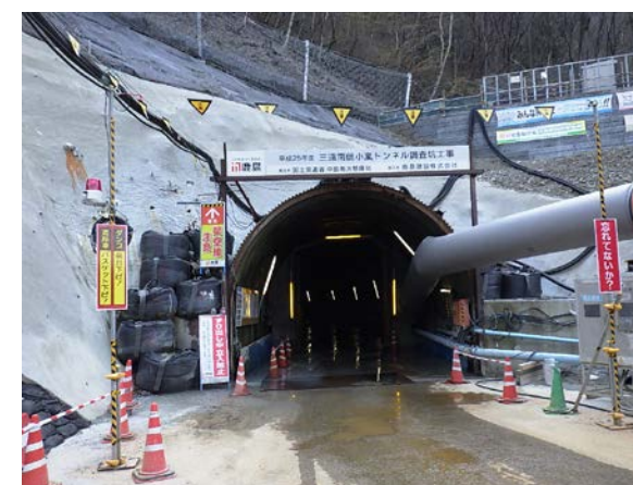
③ 調査坑坑口
