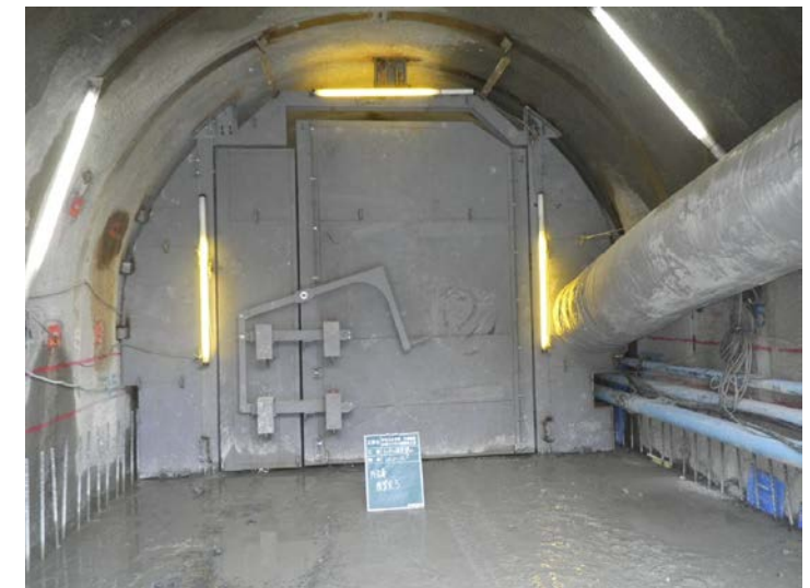
トンネル坑口 防音扉の設置
