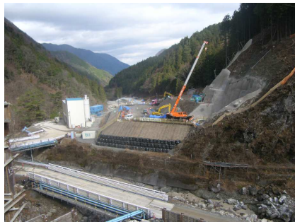
①土工-橋梁部
