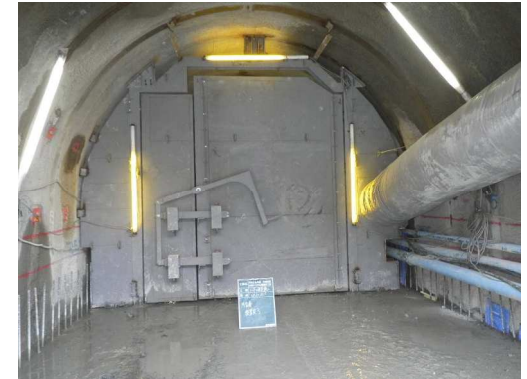
トンネル坑口 防音屏の設置
