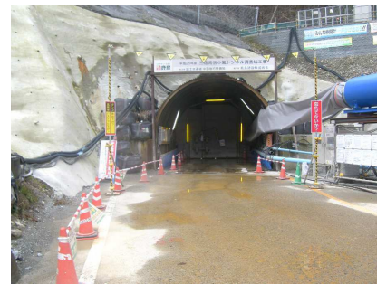
③調査坑坑口
