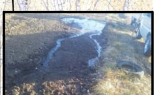
【HPφ500mm】破管による漏水
