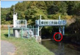
【万仁田頭首工】老朽化が著しく、堰に漏水がある。
