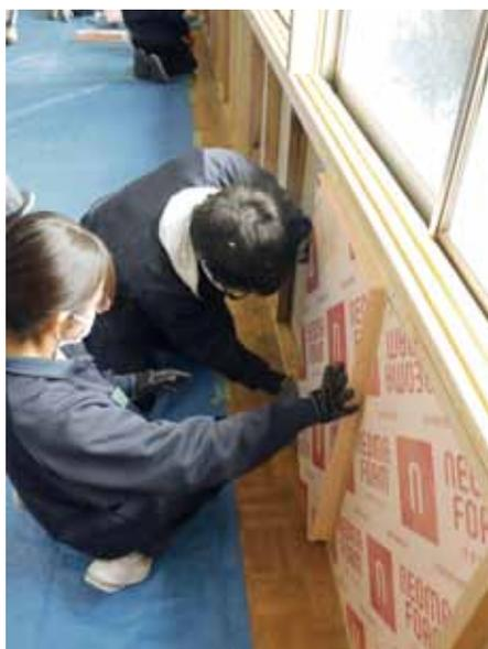
壁に断熱材をはめ込む様子
