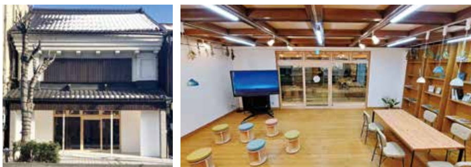
中央通り沿いの旧店舗を断熱リフォーム。室内は県内産のカラマツをふんだんに使用。
