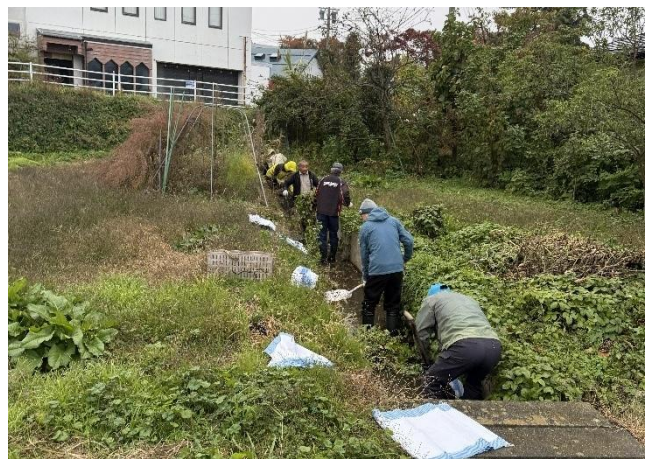
側溝の汚泥除去
