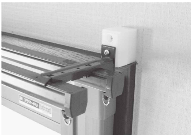
図1 カーテンレールのスペーサー
