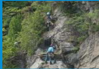
・クライマーによる崖面の作業
