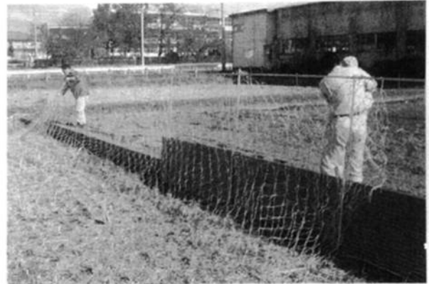
写真 1-4-2 トタンとネットを組み合わせたイノシシ用の柵を作製中（ネットの高さを 1.6m にしてシカも防除）
