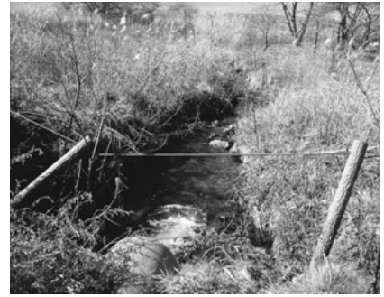
図3 雪不知沢流入路の落差 (落ち口の洗掘が顕著)
