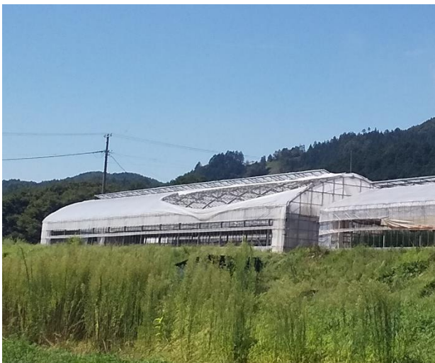
強風によるハウスビニールの剥がれ
