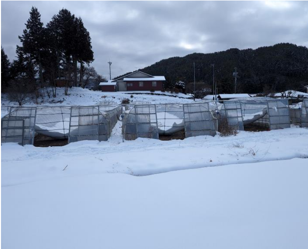
雪害によるハウス倒壊
