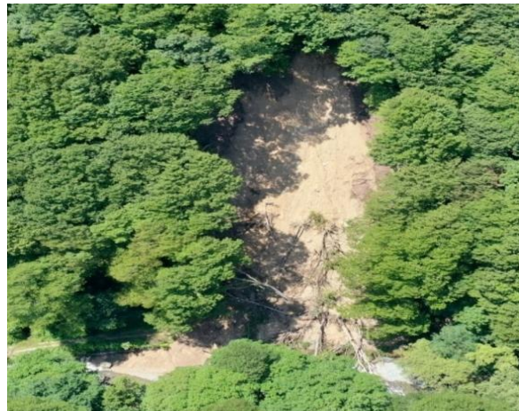
全景写真(R5.6月災害発生時)
