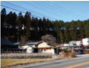
○防災・減災のための森林整備 (集落上部の間伐)
