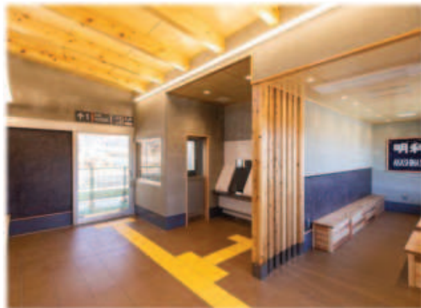
駅待合所の木質化(安曇野市) 事業主体：東日本旅客鉄道株式会社長野支社 使用樹種：カラマツ、スギ、ヒノキ等
