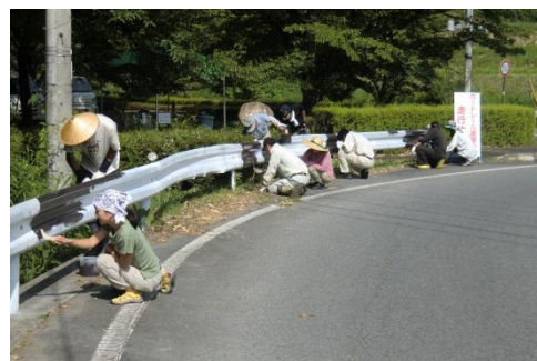
【ガードレール塗り替え作業】
