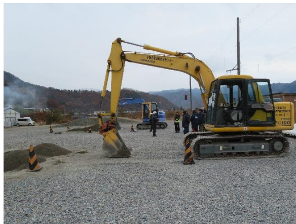
11月 バックホー運転技能研修
