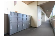
宅配BOXの設置
