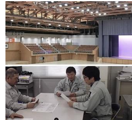
「技術専門校の訓練修了生（電気工学科）」が、地域の電気工事業界において活躍。上の写真は、訓練修了生が電気工事施工管理に携わった「長野県立武道館」
