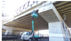
橋梁メンテナンス 橋梁点検・補修
