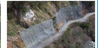
観光路線の防災対策強化 (主)駒ヶ根駒ヶ岳公園線 駒ヶ根市～宮田村 北御所
