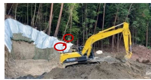
ICT施工(MG(マシンガイダンス)掘削) 丁張不要、作業員削減、安全施工
