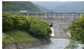
ダムメンテナンス (一)横川川 辰野町 横川ダム
