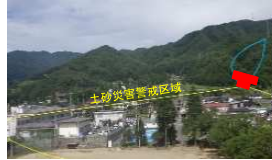
要配慮者利用施設を保全する土砂災害対策 (砂)中組 中川村 中組
