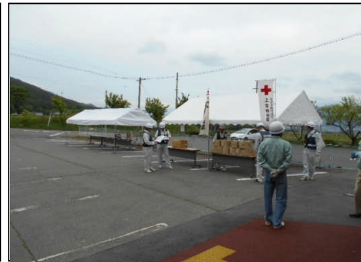
救護テントの設置状況 (〇〇市〇〇地区、〇月〇日)
