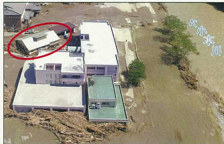
平成28年台風10号により、岩手県の要配慮者利用施設では利用者9名の全員が死亡。
