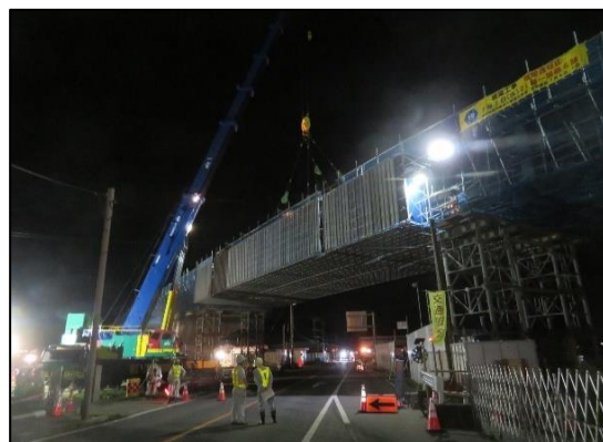
【橋梁架設後 (令和3年7月)】
