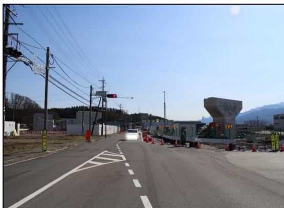
【橋梁架設前 (令和3年6月)】
