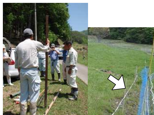
図 10 シカ用電気柵設置の様子と複線
