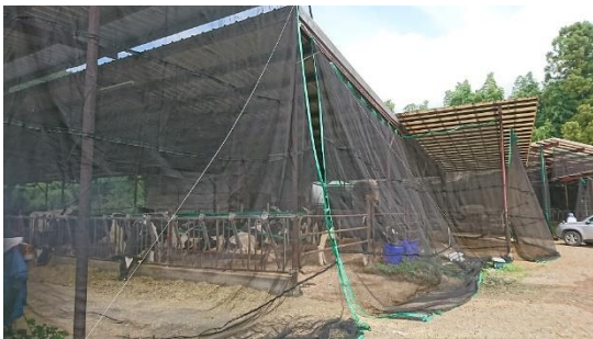
図2 防虫ネット設置風景
