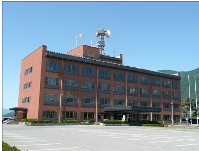
北信合同庁舎外観
