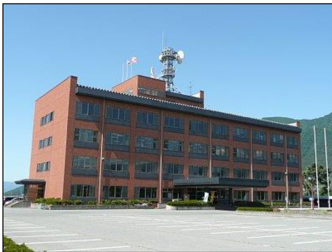
北信合同庁舎外観
