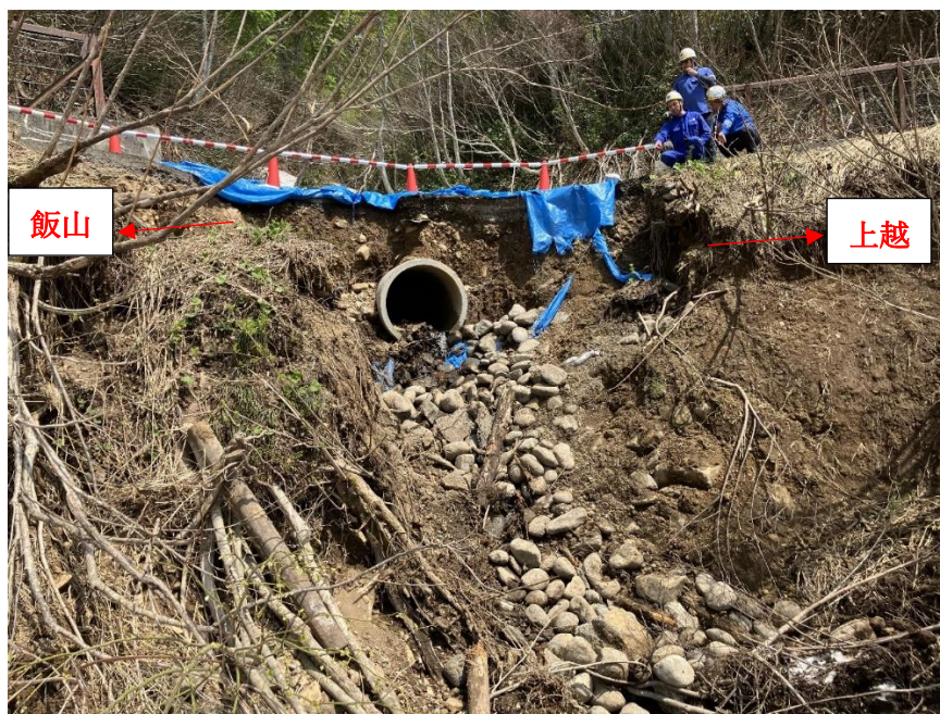
・写真②（2025.5.20 現場状況）
