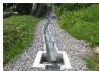
【地すべり防止工事】 （排水路工）
