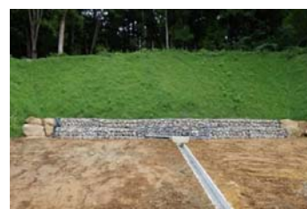
地すべり対策事業 上境地区 横孔ボーリング工
