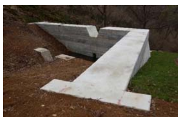
地すべり対策事業 上境地区 床固工
