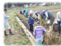
飯山市上野青空会 地域住民が排水路を補修
