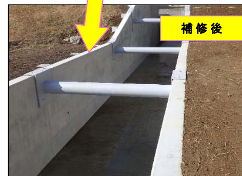
剣沢ダム洪水吐工(夜間瀬剣沢地区)
