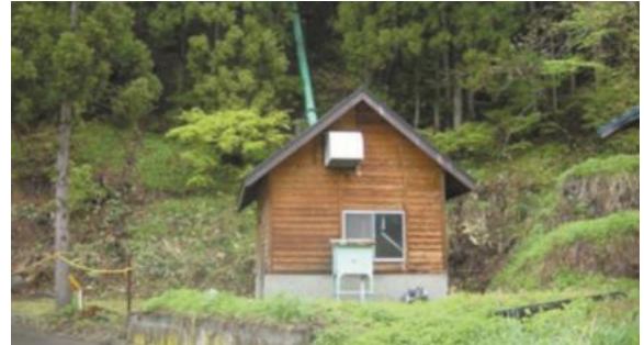
小水力発電所（木島平村）
