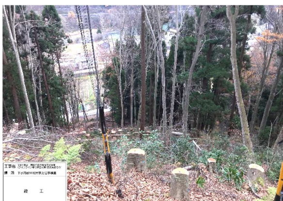
整備後（電線沿いを一定幅で伐採）
