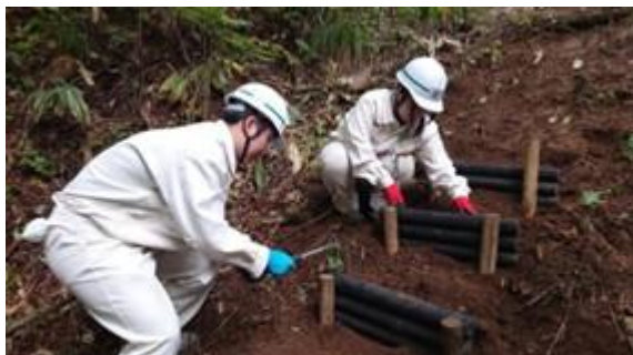
歩道の整備状況
