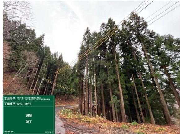
整備後（電線隣接木を伐採）
