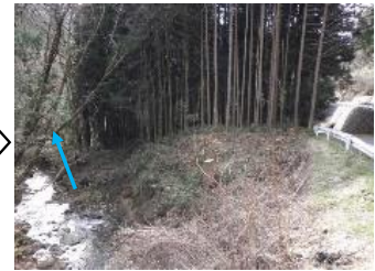
県管理河川の除間伐（木曽町 一級河川桂川）
