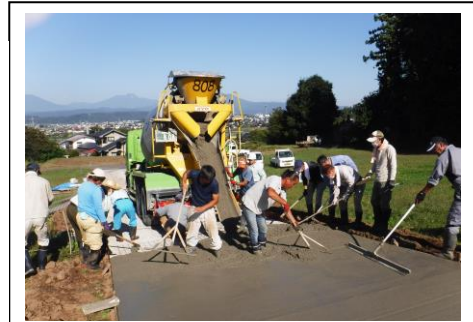
【農道舗装の様子】
