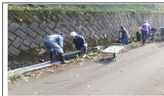
(下須賀川地区 作業の様子)
