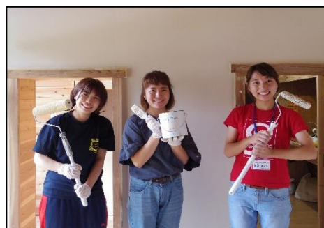
【学生と協働で内装工事を実施】
