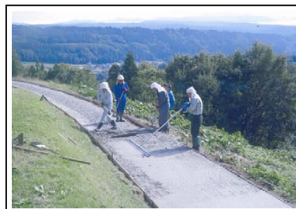
【生コン打設状況】
