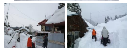
【除雪・排雪作業】
