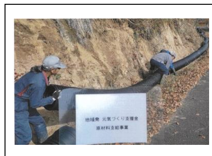
【プレスト管敷設状況】
