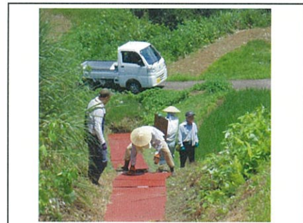
【縞鋼板敷設状況】
