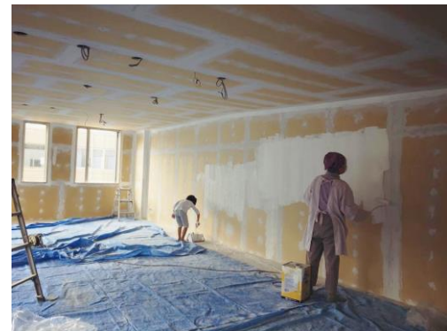
【改修作業の様子】
