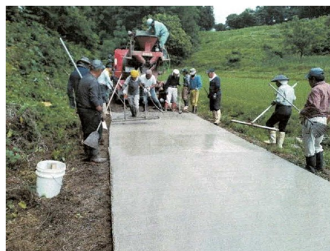
【農道の舗装作業】
