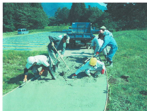
【農道の舗装作業】
