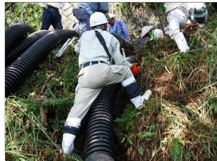
【パイプ敷設状況】
